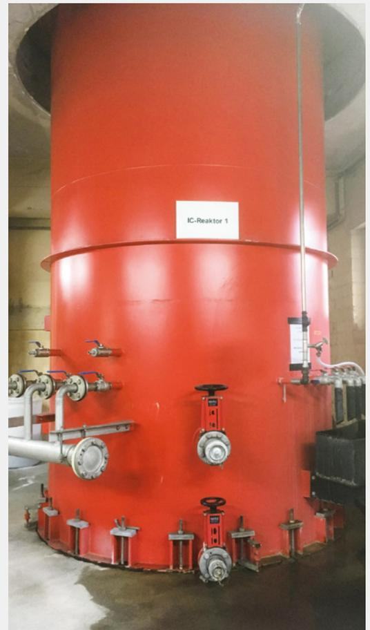
Fig. 4 Biogasreaktor der ARA
