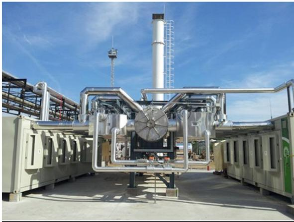
2-MW Mikrogasturbinenanlage auf einem Gasfeld
